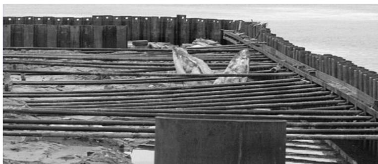
Рисунок 6. Повреждение после паводка стальных тяг, фиксирующих положение стального шпунта «Ларсена» (справа – глыбы льда и деформированные тяги)
