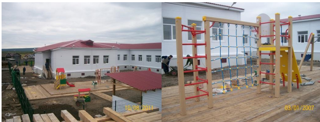
Рис.5. Детский сад в пос. Ессей, отвечающий самым высоким строительным и эксплуатационным стандартам
